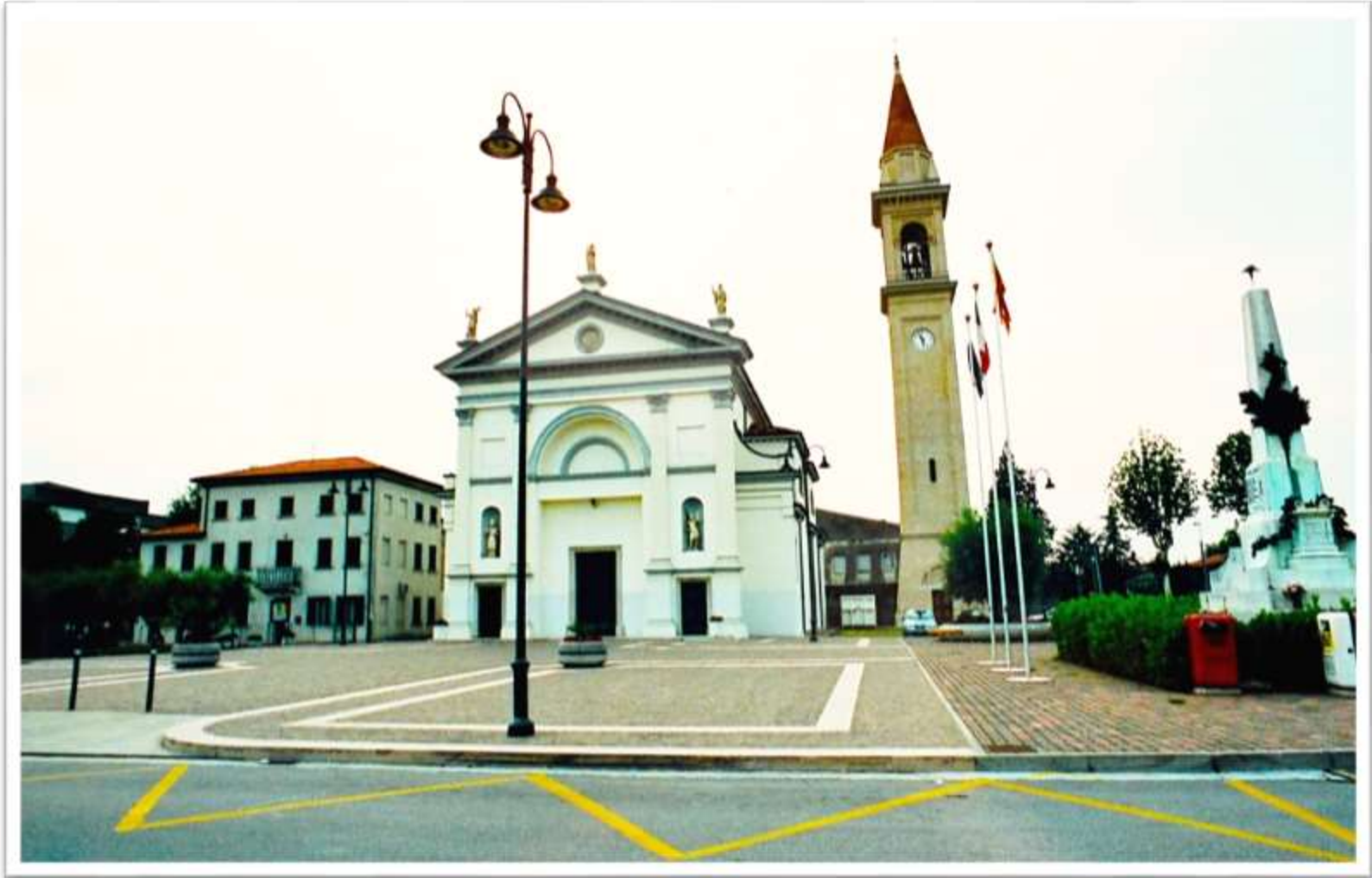
La Chiesa della frazione di Passarella
