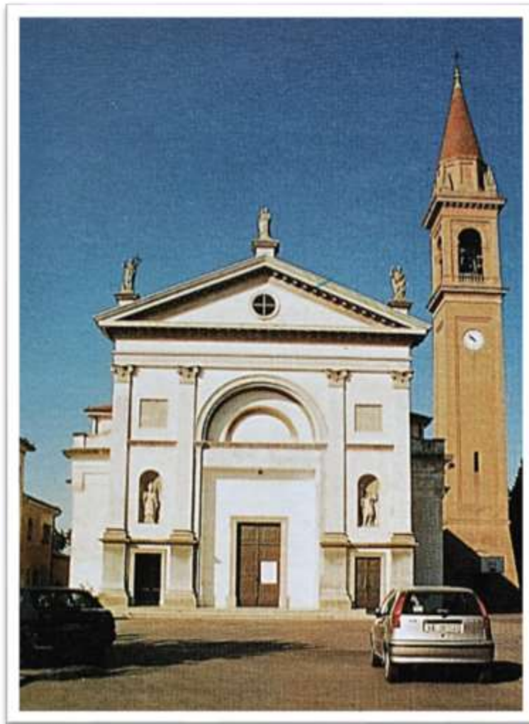
La Chiesa della frazione di Passarella
