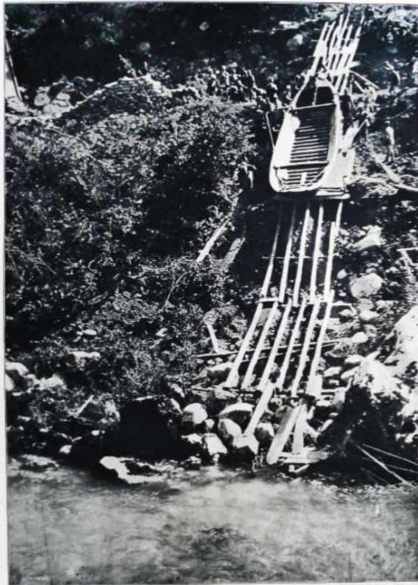
La costruzione di uno dei ponti sull'Isonzo a nord di Tolmino.
