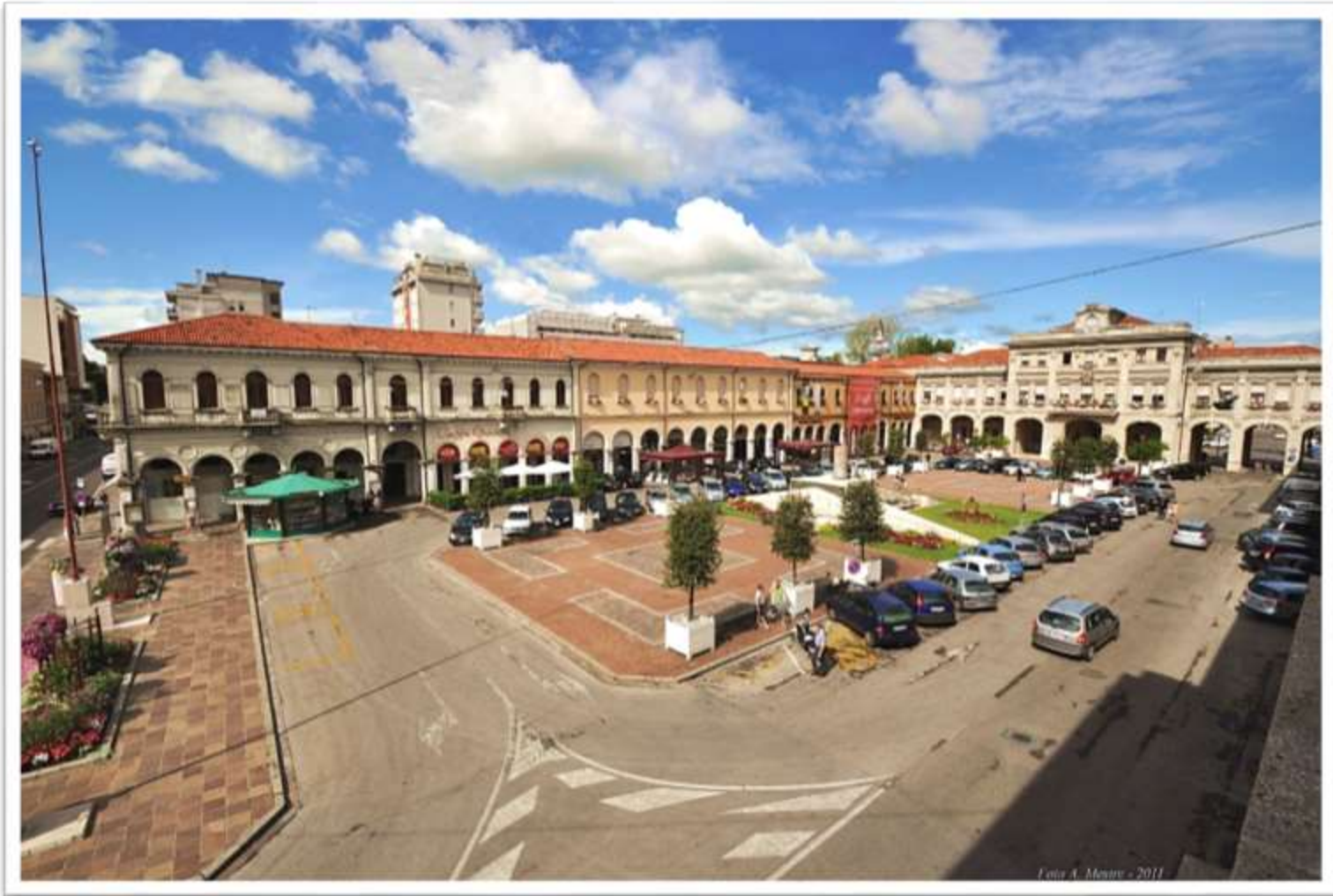
San Donà di Piave panoramica della piazza Indipendenza prima della nuova sistemazione
