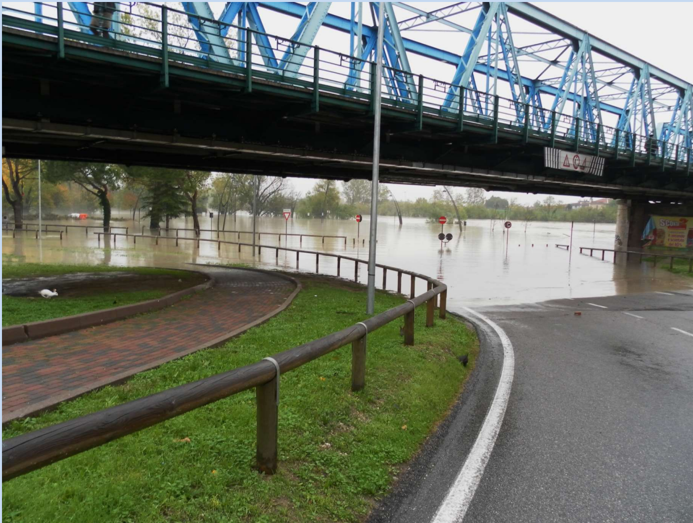
La strada allagata sotto il ponte della Vittoria lato San Donà di Piave sullo sfondo il parco completamente allagato
