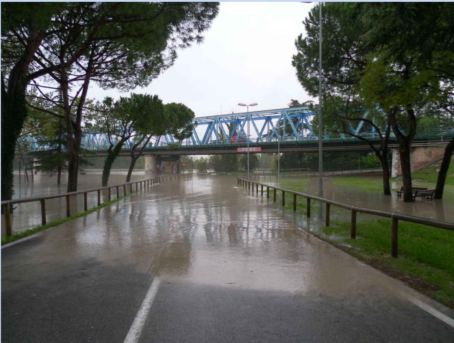
La strada sotto il ponte allagata
