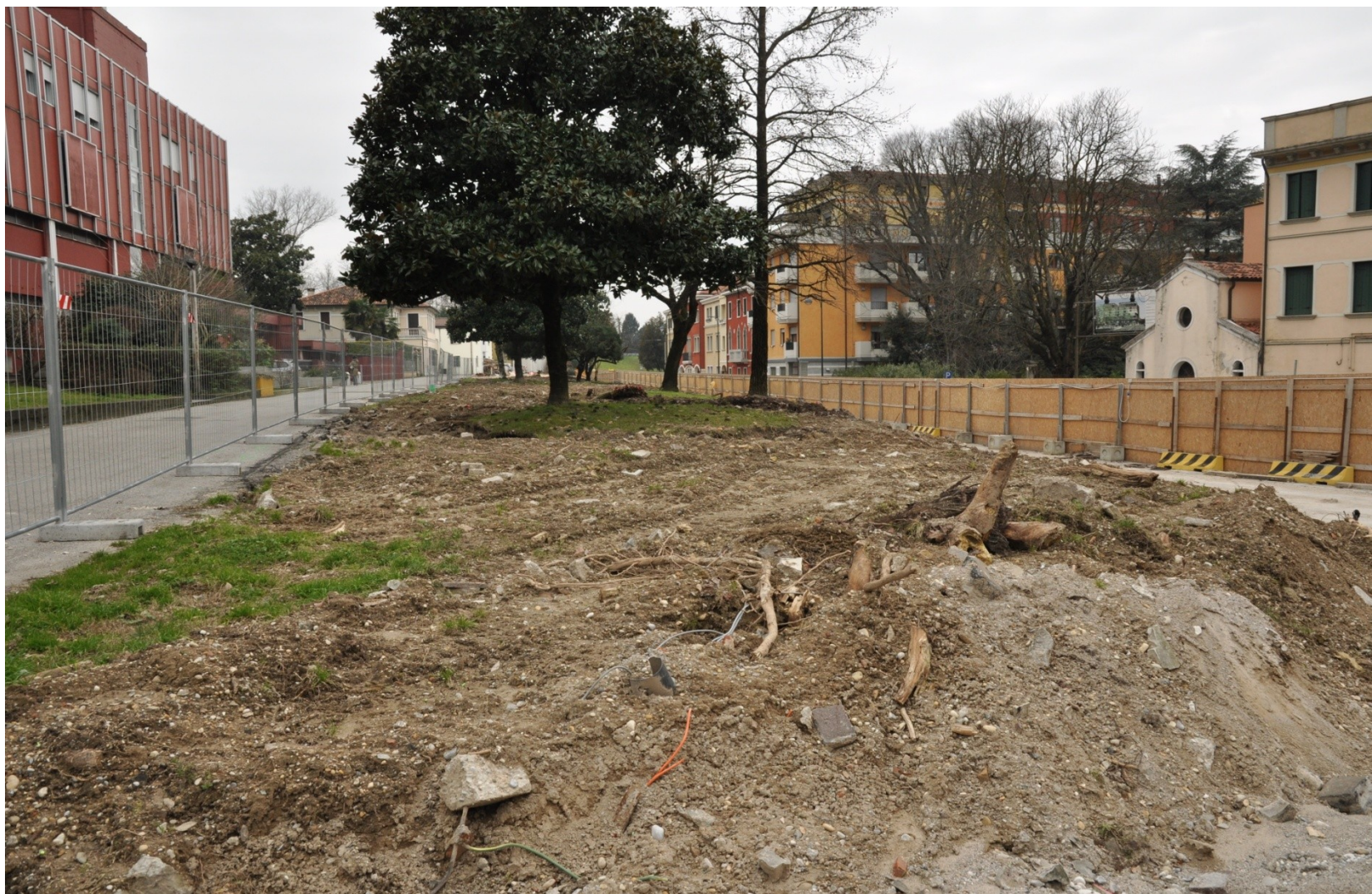
Archivio Fotografico club 54 San Donà di Piave inizio dei lavori del nuovo parcheggio giardino
